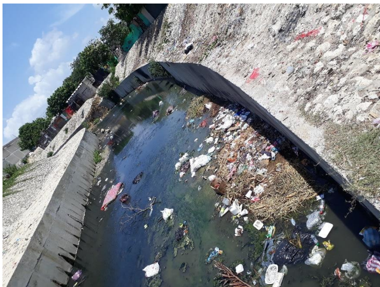
Fotografía 4-9. Vertimiento Calle 30 Carrera 13
