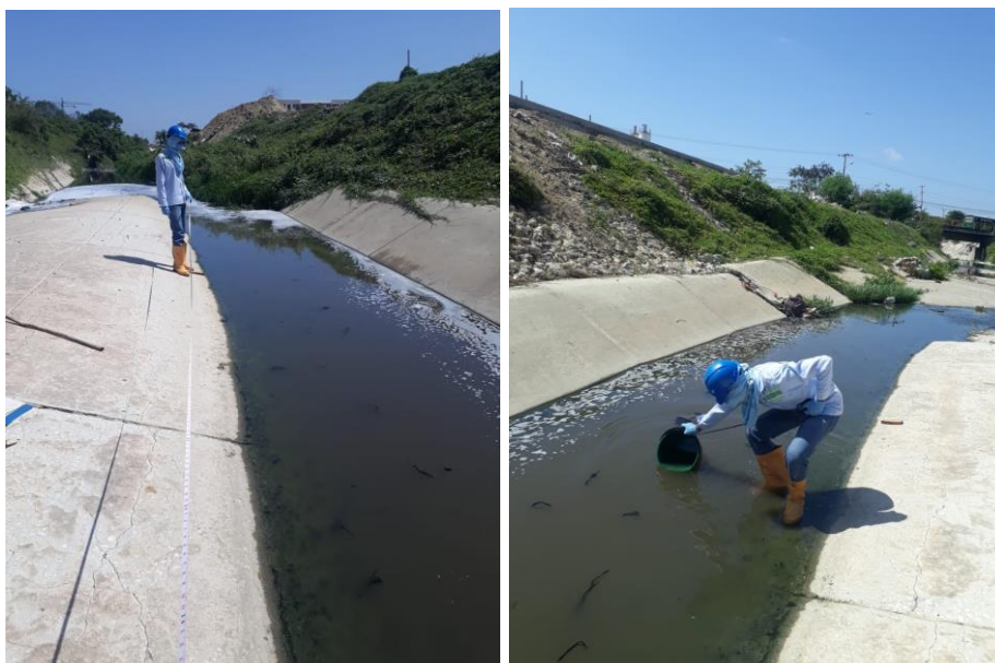
Fotografía 4-2. Vertimiento carrera 17 Calle 16 (Arroyo El Platanal)
