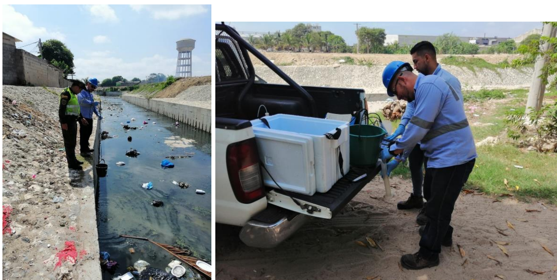
Fotografía 4-16. Vertimiento Calle 31A Cr 15D
