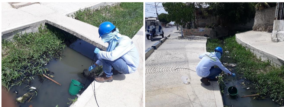
Fotografía 4-4. Carrera 26 Calle 27 presencia de vegetación y material flotante.
