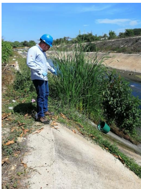
Fotografía 4-17. Vertimiento CII 10 Cra 12 Arroyo El Platanal
