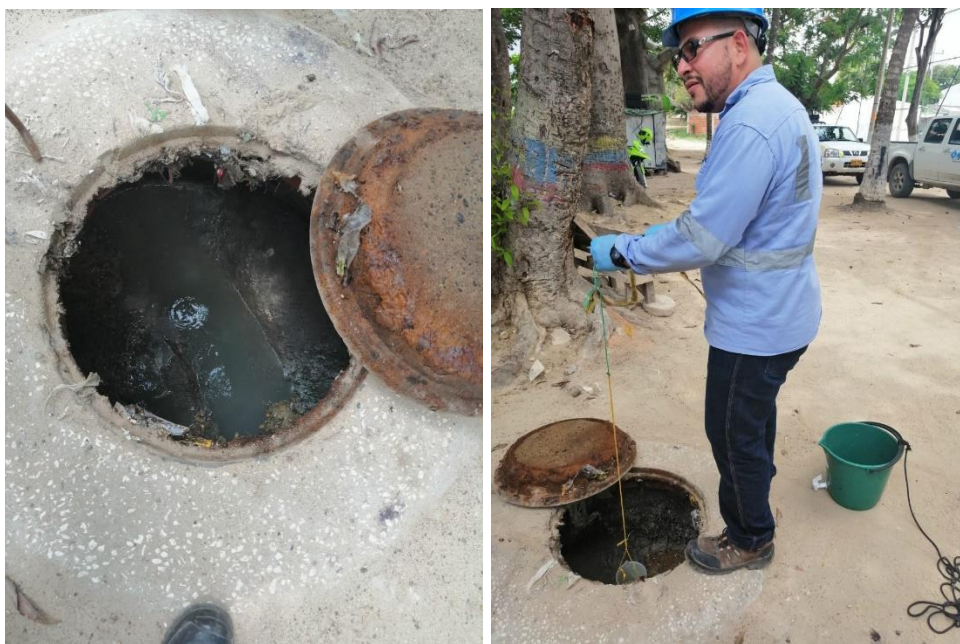
Fotografía 4-15. Vertimiento Calle 31A Cr 15D
