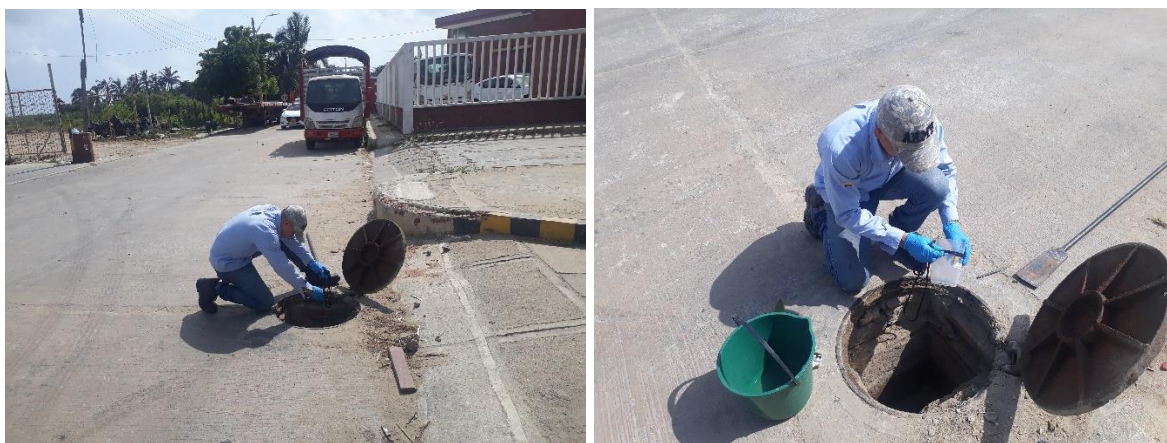
Fotografía 4-28. Vertimiento Calle 69 Estación Felicidad Río Magdalena
